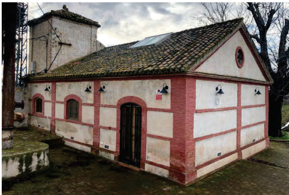
Fotografía del exterior de la edificación
