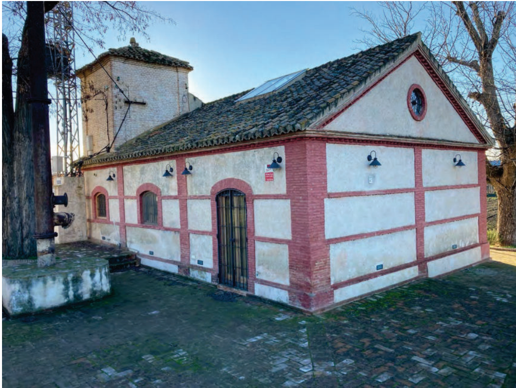
Figura 20.- Vista general del conjunto
