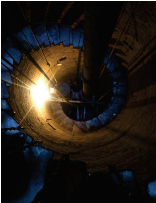
Fotografía interior del pozo desde arriba hacia abajo
