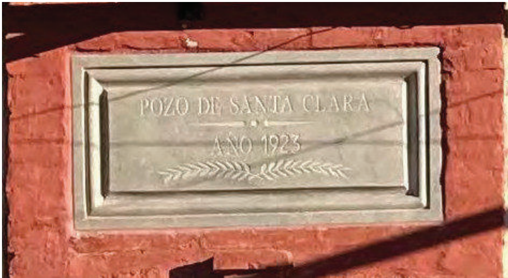
Figura 18 y 19.- Detalle de la fachada principal. Puerta de acceso e inscripción fundacional en piedra de Sierra Elvira
