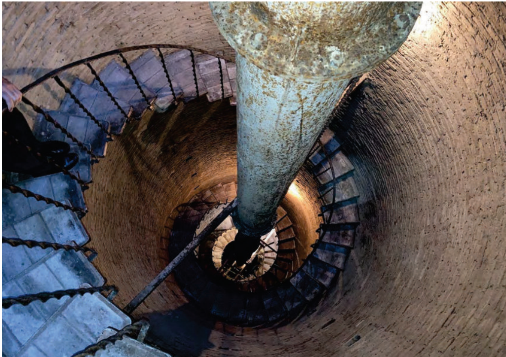
Figura 9.- Vista general del pozo desde su coronación
