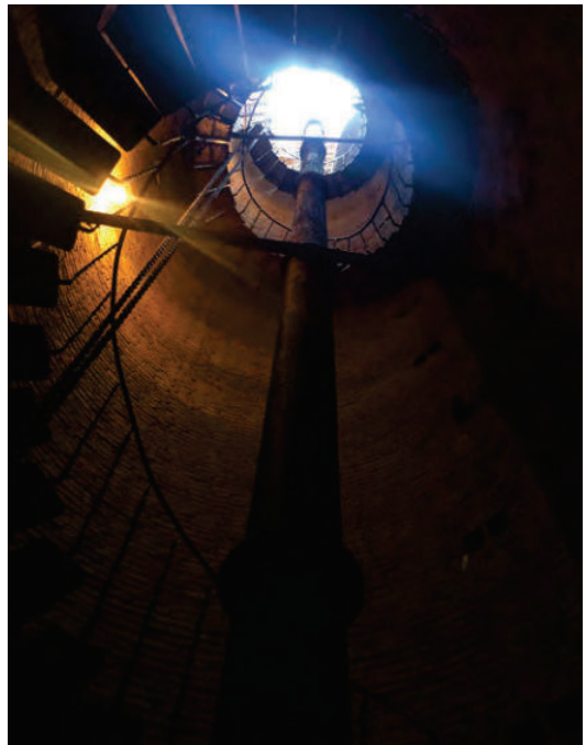
Fotografía interior del pozo desde abajo hacia arriba
