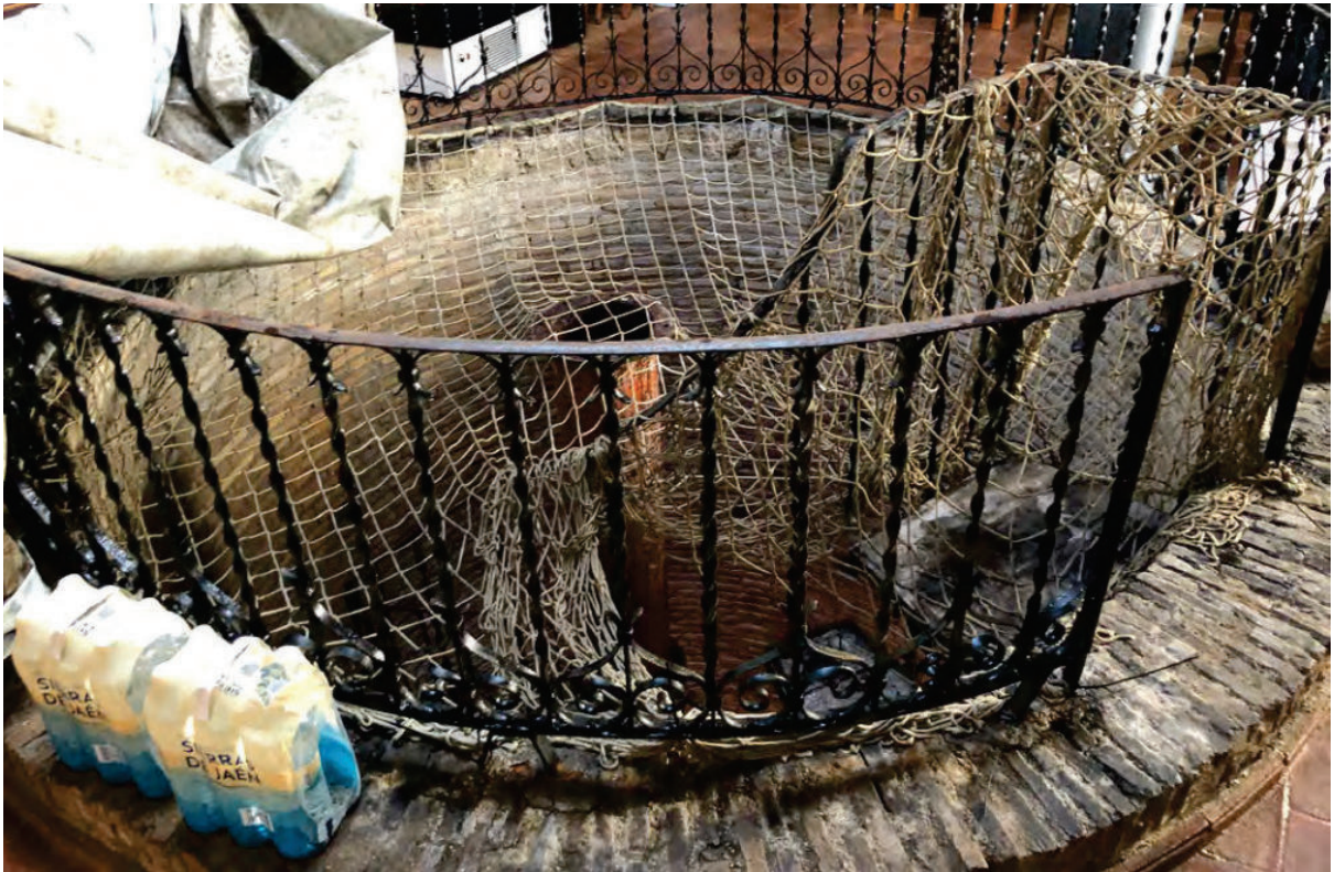
Fotografía del exterior del pozo desde el interior de la edificación
