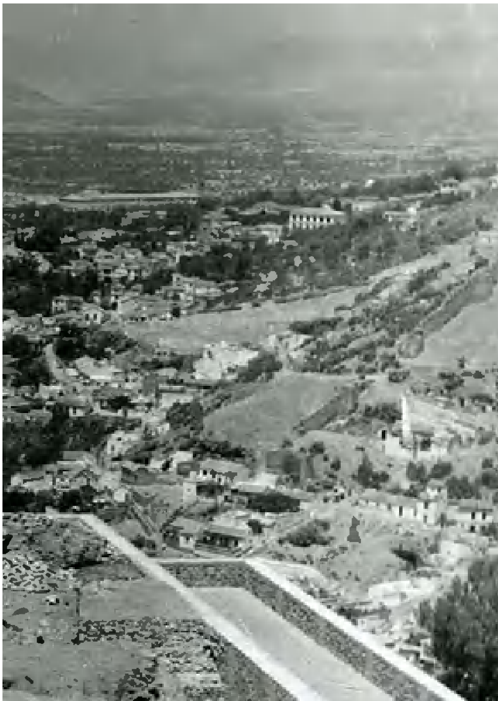
Figura 1.108. Detalle de la fotografía de las obras de reconstrucción en el Castillo de Santa Elena en el Generalife. 1965.
