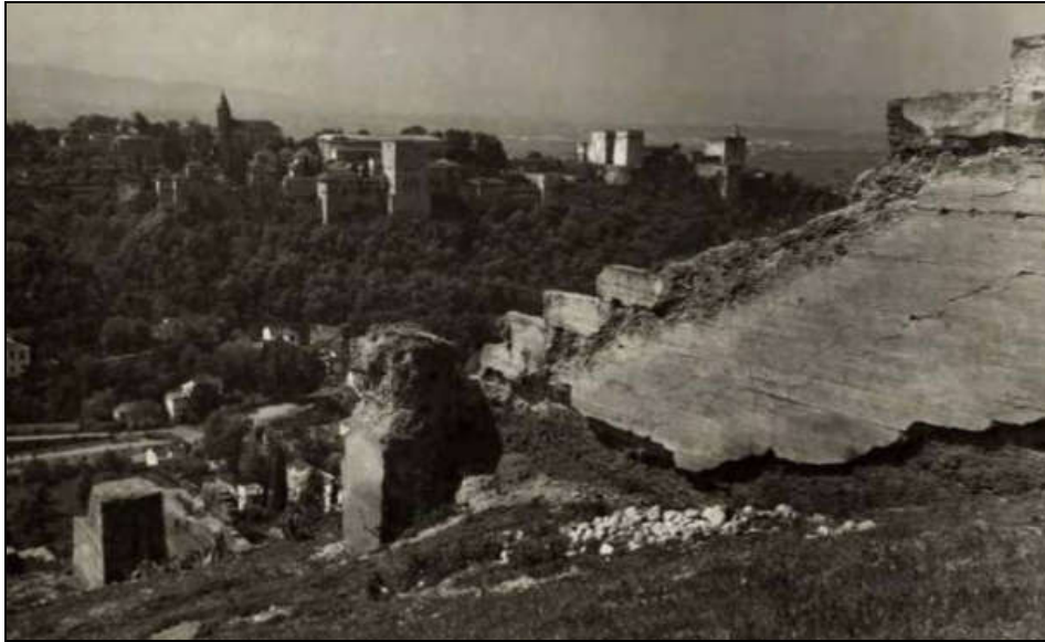
Figura 2.16. F. Prieto-Moreno Pardo, 1960. "Obras de recalce en el sector de la cerca de Don Gonzalo". AGA, Sección Cultura, 26/00150.
