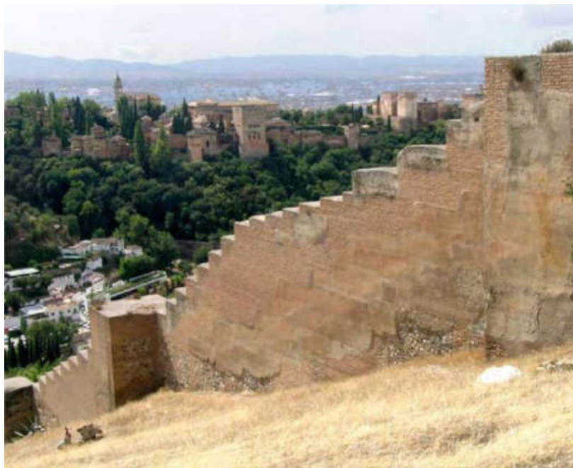
Figura 2.5. Lienzo de muralla escalonado y torre Q, situados entre la Ermita de San Miguel y la Verea de Enmedio. J. M. López Osorio, 2015.
