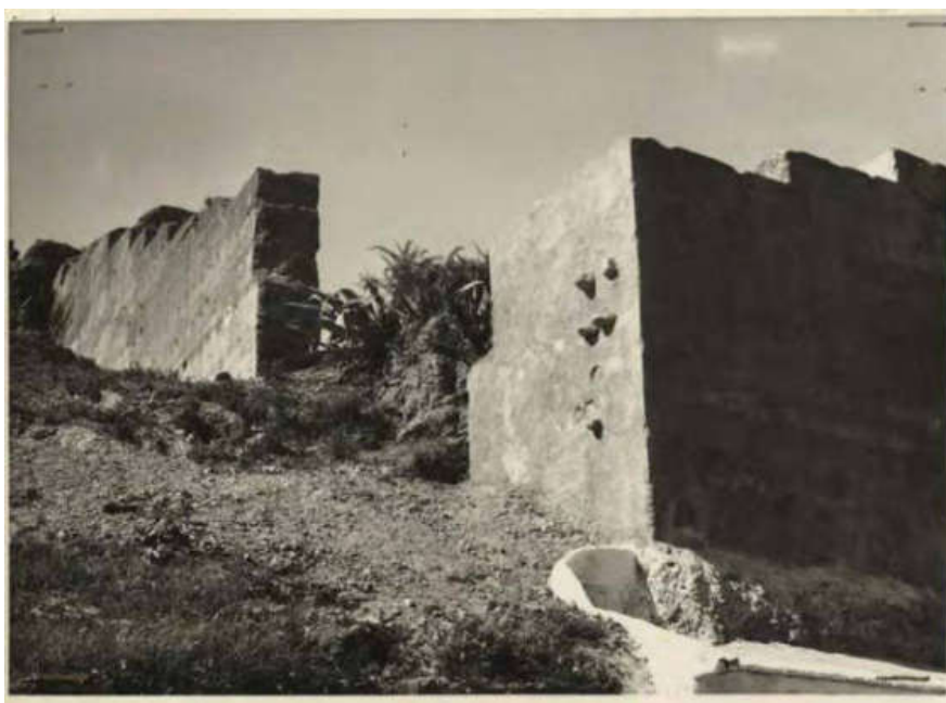
Figura 2.13. F. Prieto-Moreno Pardo, 1958. Murallas del Albaicín. Vereda de Enmedio. Obras de recalce en el sector de muralla entre la Vereda de En medio y la Ermita de San Miguel. AGA, sección Cultura, 26/00157.
