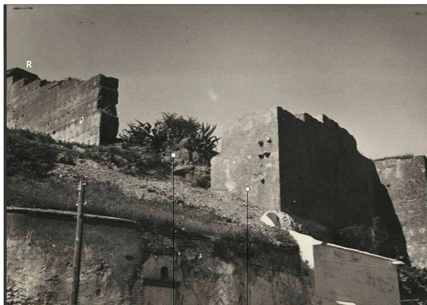
Quiebro sobre la Verea de Enmedio Intervención de F. Prieto-Moreno (1950-1957) Brecha entre torre R y quiebro Se conserva el núcleo de la tapia de la base del lienzo
