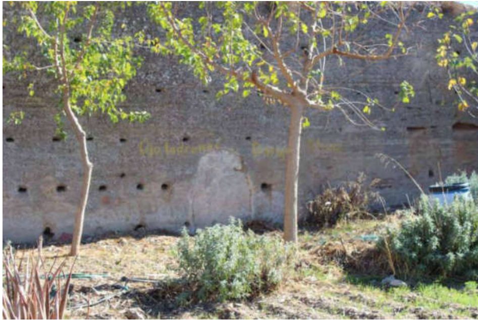
Figura 2.32. Portillo cegado durante la intervención de A. Jiménez Torrecillas, 2005. S. Peñalver Martín, 2022.
