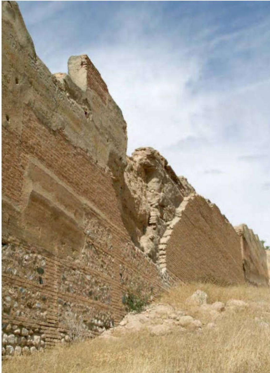
Figura 2.24. Prieto-Moreno. Sectores degradados, intervenidos en 2019. Muralla del Cerro de San Miguel. J. M. López Osorio, 2006.
