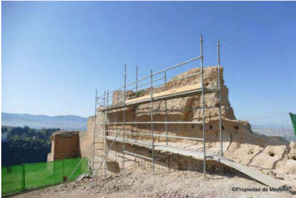
Figura 2.36. Intervención de I. Bestué Cardiel, 2019. "Obras de emergencia en la muralla nazari o Cerca de Don Gonzalo del Sacromonte de Granada". M. Martínez Caro, 2020.
