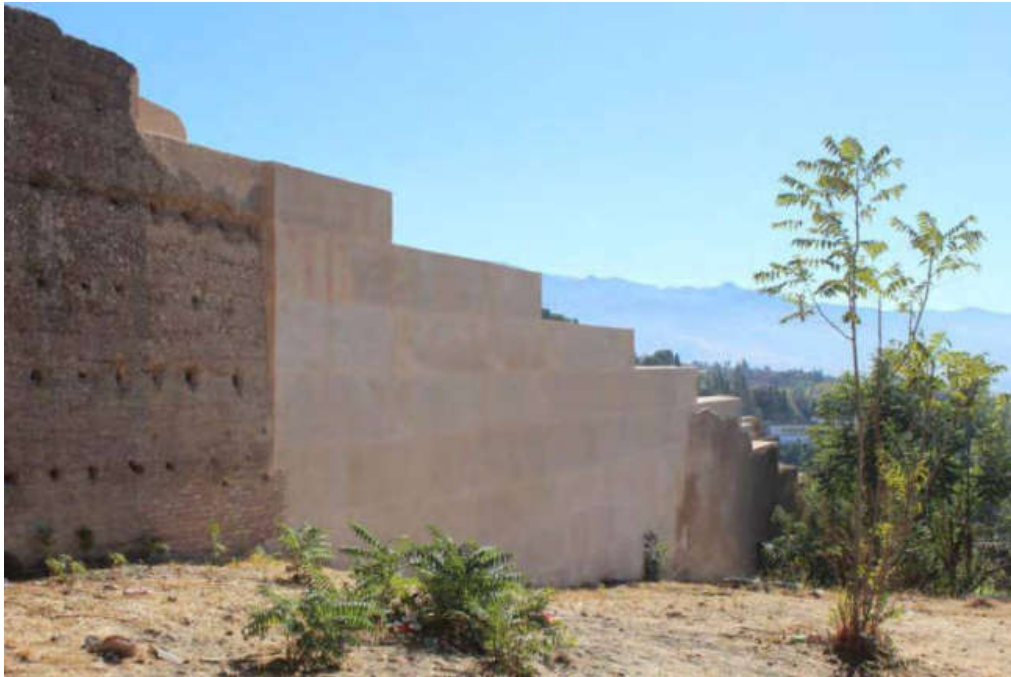
Figura 2.38. Intervención de I. Bestué Cardiel, 2019. "Obras de emergencia en la muralla nazarí o Cerca de Don Gonzalo del Sacromonte de Granada". S. Peñalver Martín, 2022.
