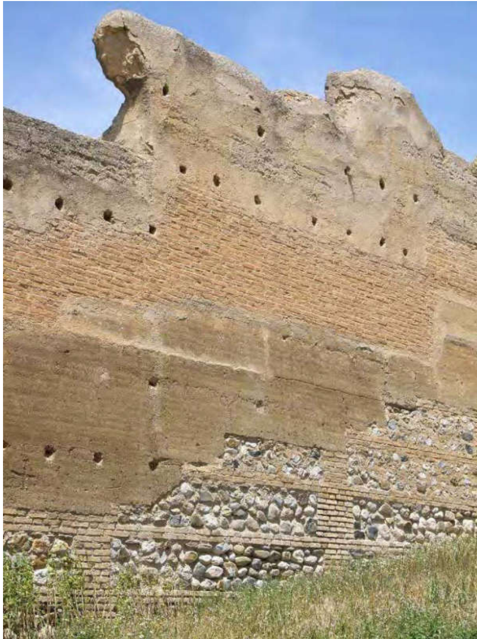
Figura 2.22. F. Prieto-Moreno Pardo. Recalce con fábrica de mampostería y ladrillo. Muralla del Cerro de San Miguel. J. M. López Osorio, 2006.
