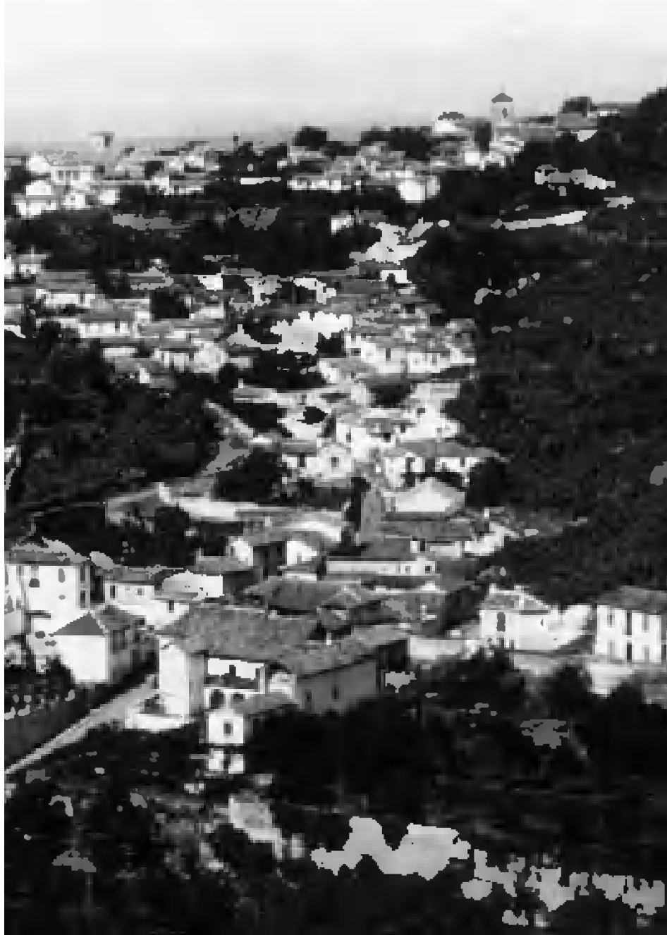
Figura 1.74. Detalle de la fotografía sobre el Albaicín. Sigurd Curman, 1910.
