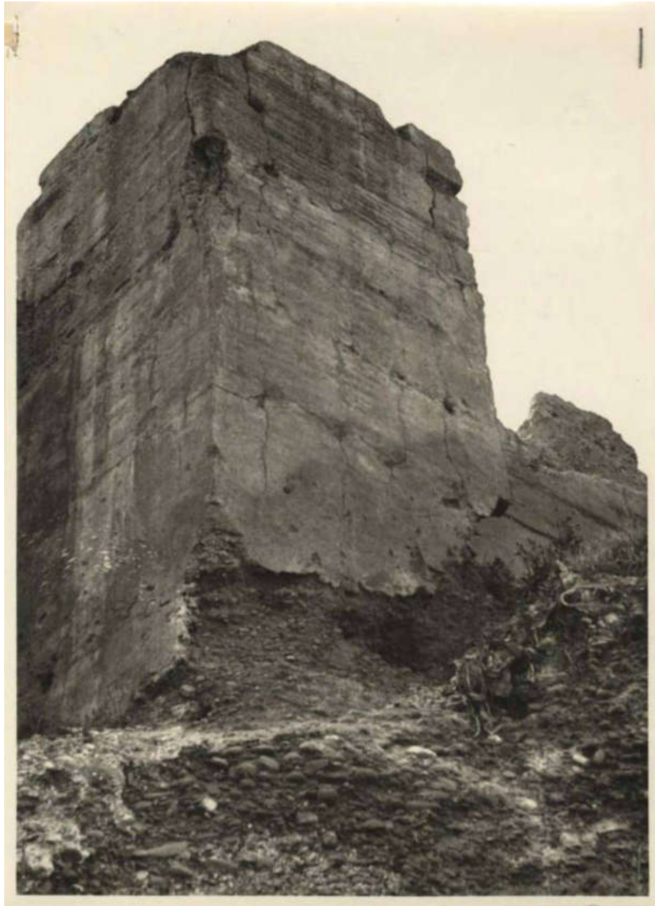
Figura 2.11. F. Prieto-Moreno Pardo, 1958. Murallas del Albaicín. Vereda de Enmedio. Obras de recalce en el sector de muralla entre la Verea de Enmedio y la Ermita de San Miguel. AGA, sección Cultura, 26/00157.
