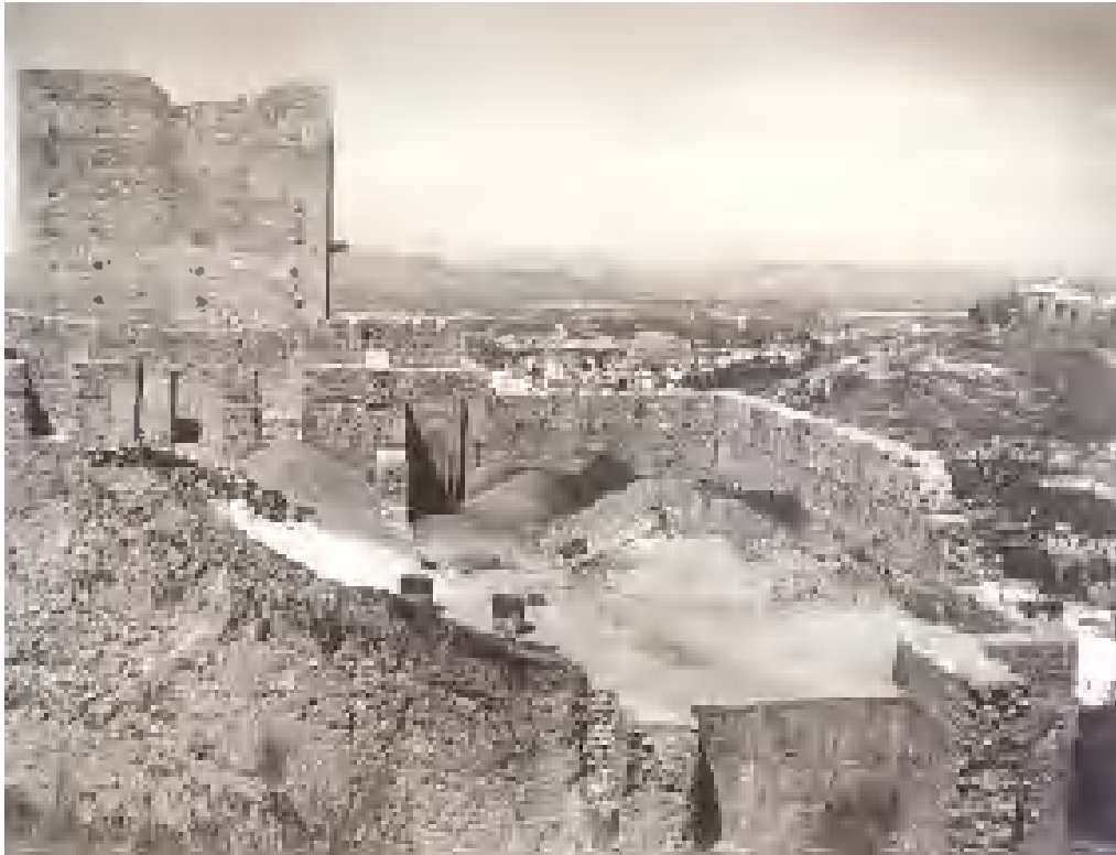
Figura 1.111. Proyecto de conservación y restauración del Castillo de Santa Elena. 1968.
