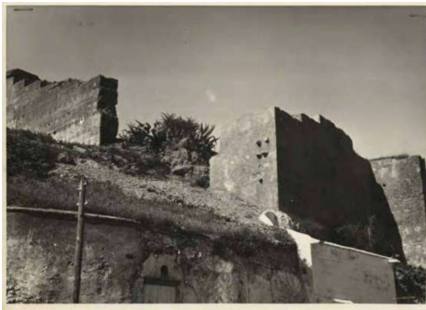
Figura 2.12. F. Prieto-Moreno Pardo, 1958. Murallas del Albaicín. Vereda de Enmedio. Obras de recalce en el sector de muralla entre la Vereda de Enmedio y la Ermita de San Miguel. AGA, sección Cultura, 26/00157.
