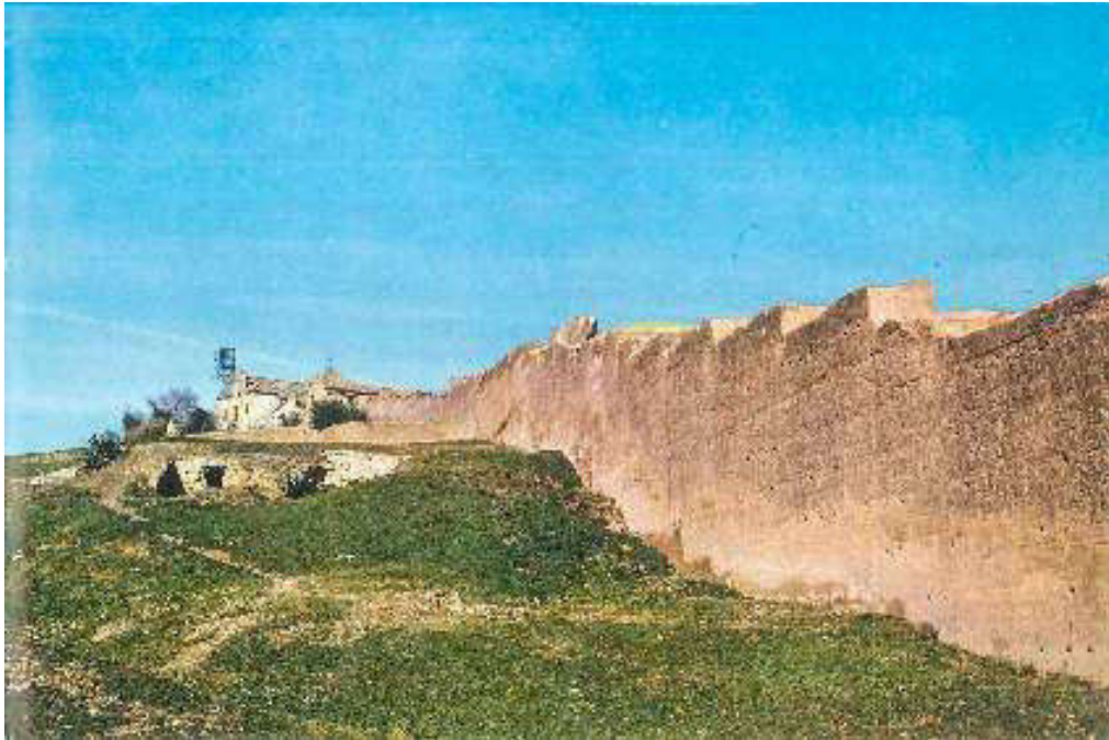
Figura 1.121. La cerca exterior, de Don Gonzalo, cerca de San Miguel el Alto. Luis Seco de Lucena Paredes - Fotocolor Valdivieso, anterior a 1974.
