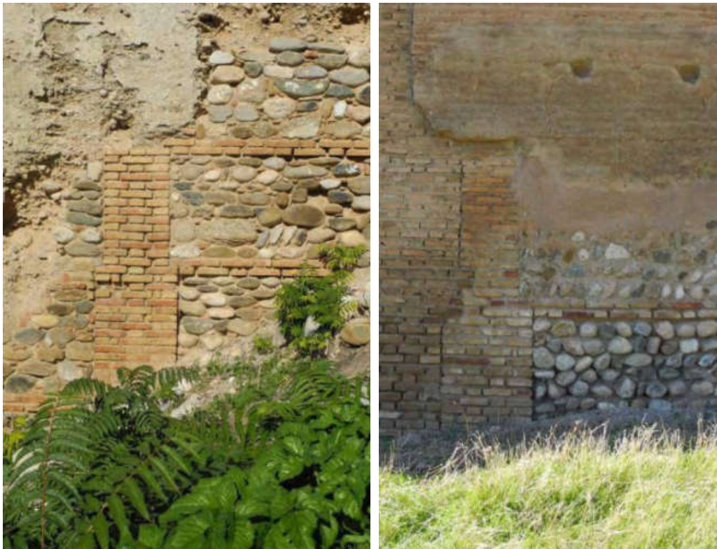
Figura 2.21. F. Prieto-Moreno Pardo. Recalce de lienzos con fábrica mixta de mampostería y ladrillo. Muralla del Cerro de San Miguel. J. M. López Osorio, 2015.
