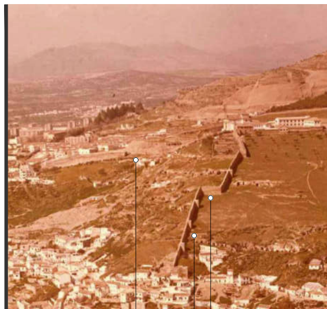
Brecha entre torres J-K Recalce de la base de la muralla Lienzos entre torres Q, R y quiebro reconstruidos Intervenciones de F. Prieto-Moreno y J. Prieto-Moreno
