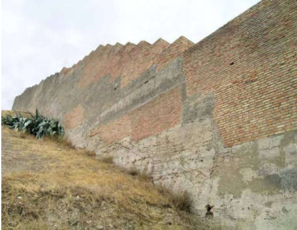
Figura 2.23. F. Prieto-Moreno Pardo. Consolidación y reintegración de perfiles con fábrica de ladrillo. Muralla del Cerro de San Miguel. J. M. López Osorio, 2006.
