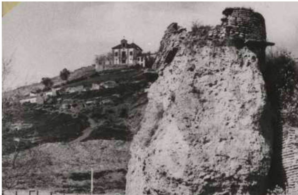
Figura 1.116. Detalle de la fotografía de la muralla zirí en el entorno de la Iglesia del Salvador, con el Cerro de San Miguel en segundo Plano. Joaquín Prieto-Moreno, 1972.
