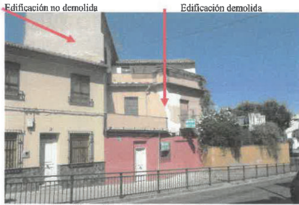
1-Foto de la edificación de Carretera de Murcia antes de su demolición en 2.010. Se marca también la edificación no demolida perteneciente a la parcela de C/Yeseros nº 7.
