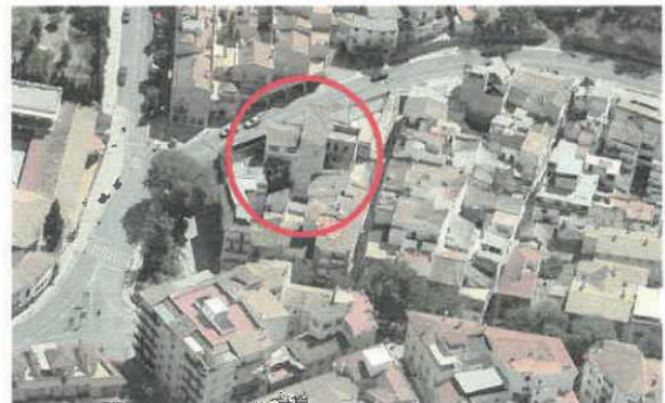
6-Fachada oeste en 2.010
