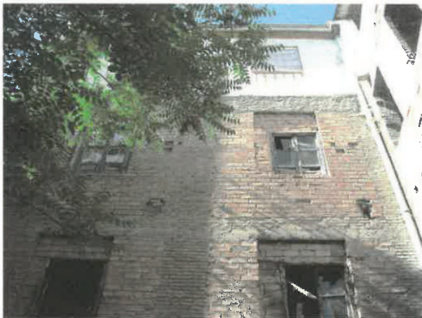
2-Edificación de C/ Yeseros nº 7 a patio que figuraba erróneamente anexionada a la parcela de Carretera de Murcia nº 2.
