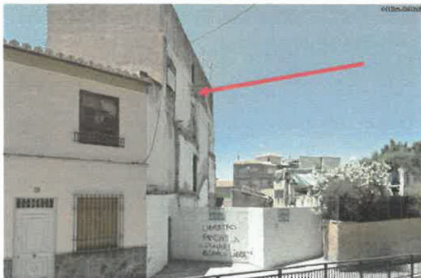
3-Fachada actual a Carretera de Murcia. Se aprecia la edificación demolida y el cuerpo edificado perteneciente al solar de C/ Yeseros nº 7
