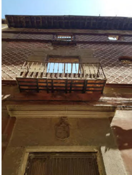
Fachada hacia Santa Ana
