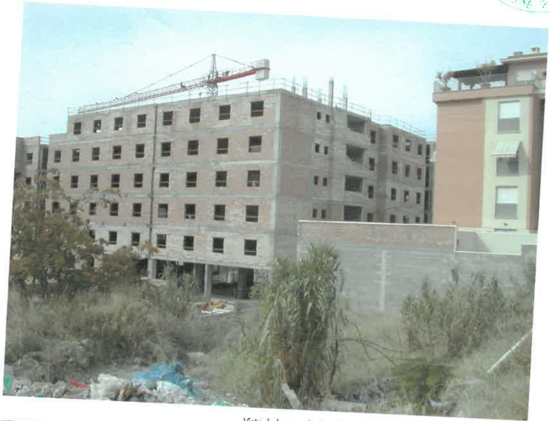
Vista de la parcela desde la calle Rauda, al fondo la edificación hotelera
