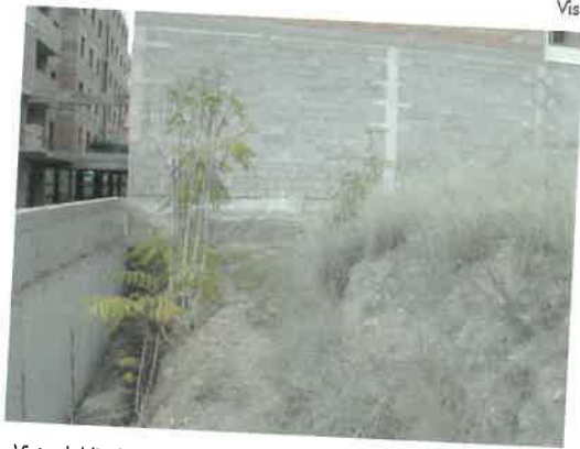
Vista del lindero oeste con la edificación residencial plurifamiliar
