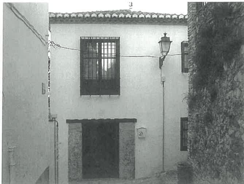
Fotografía nº2: Alzado principal vivienda nº11.
