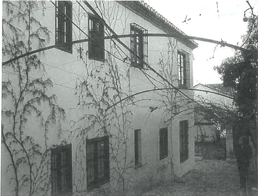
Fotografía n°7: Alzado posterior vivienda n°11.
