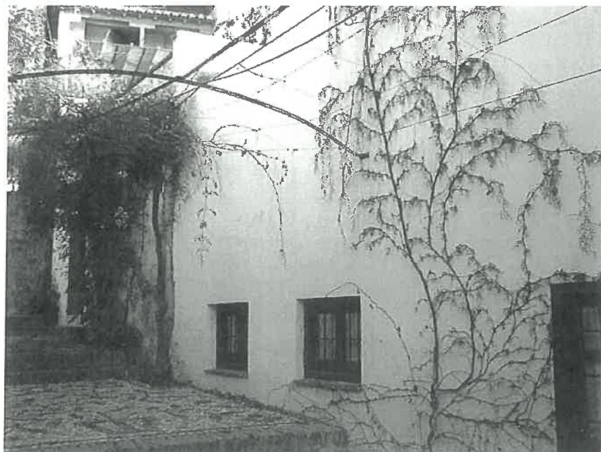
Fotografía n°8: Alzado posterior vivienda n°13.
