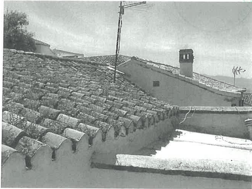
Fotografía n°5: Vista de alero de cubierta de vivienda n°13 y hastial de vivienda n°11.
