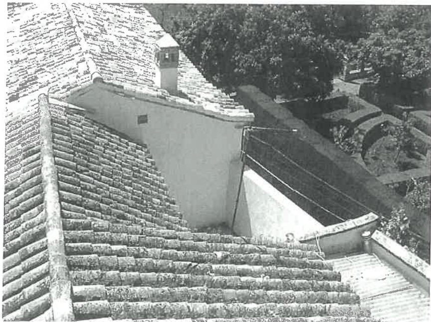
Fotografía n°6: Vista general de cubierta y patio de luces.
