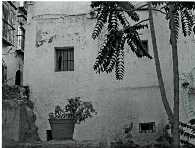
Planta primera . Vista desde las escaleras
