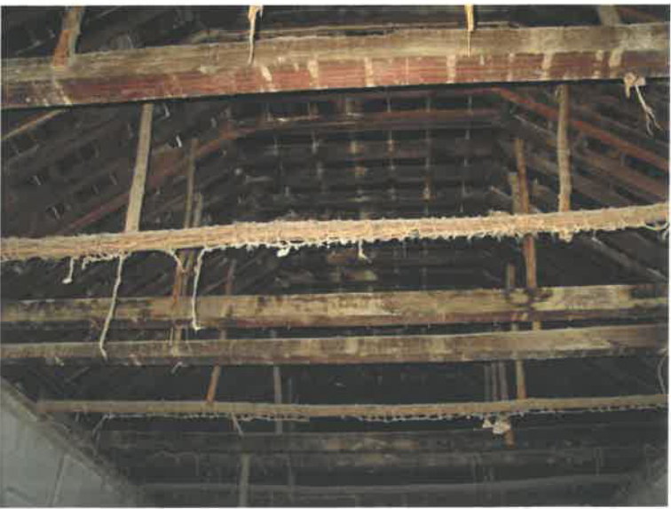
TECHOS DE LAS PLANTAS BAJA, PRIMERA Y SEGUNDA DE LA CRUJÍA PRINCIPAL
