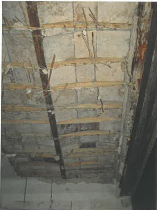
NUEVO SISTEMA DE FORJADOS EMPLEADOS
