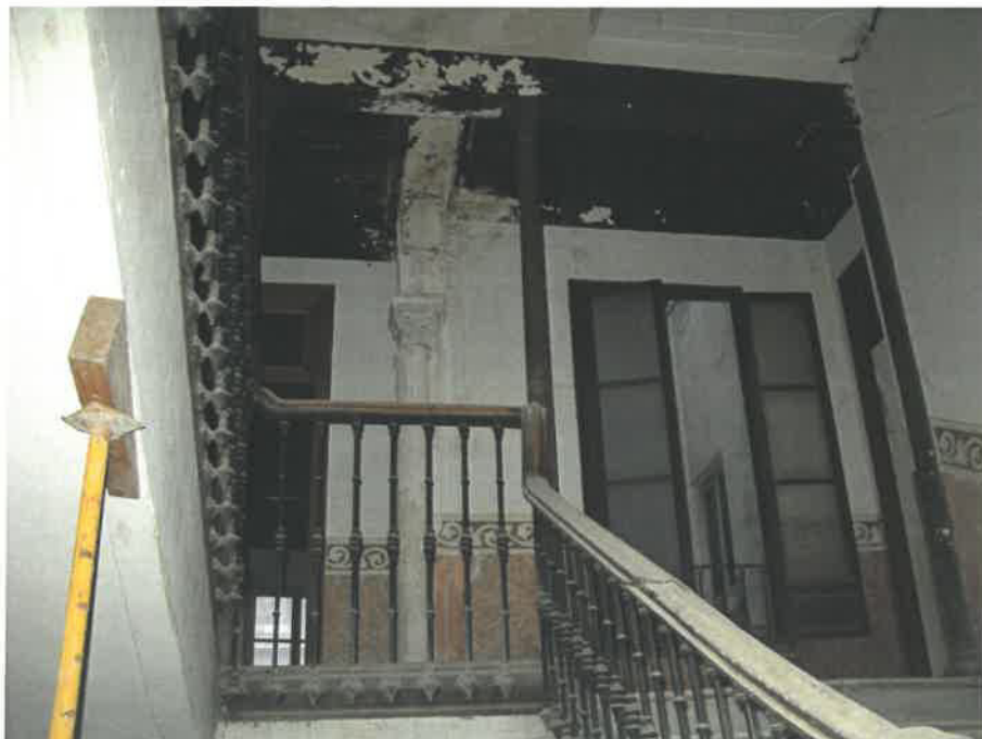
NUEVA CAJA DE ESCALERA
