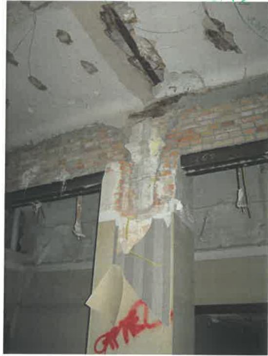
DETALLE DE COLUMNAS EMBUTIDAS
