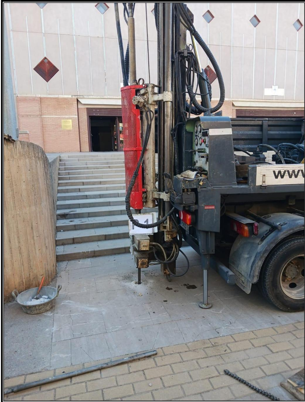
**Ensayo de penetración DPSH-1**
