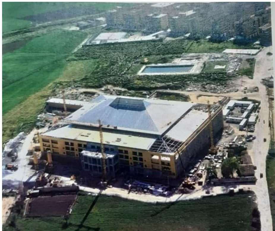
2.2. MONTAJE DE LA CUBIERTA
