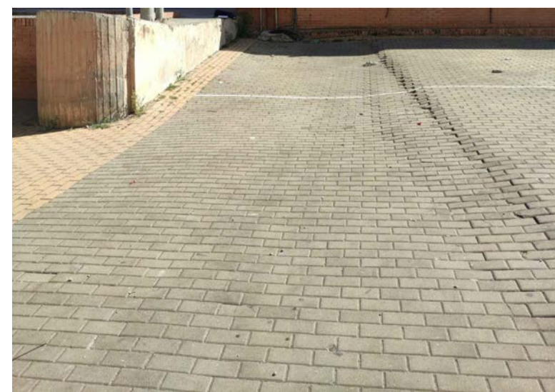
Reparación general del pavimento Especialmente zona del túnel y zonas próximas a imbornales
