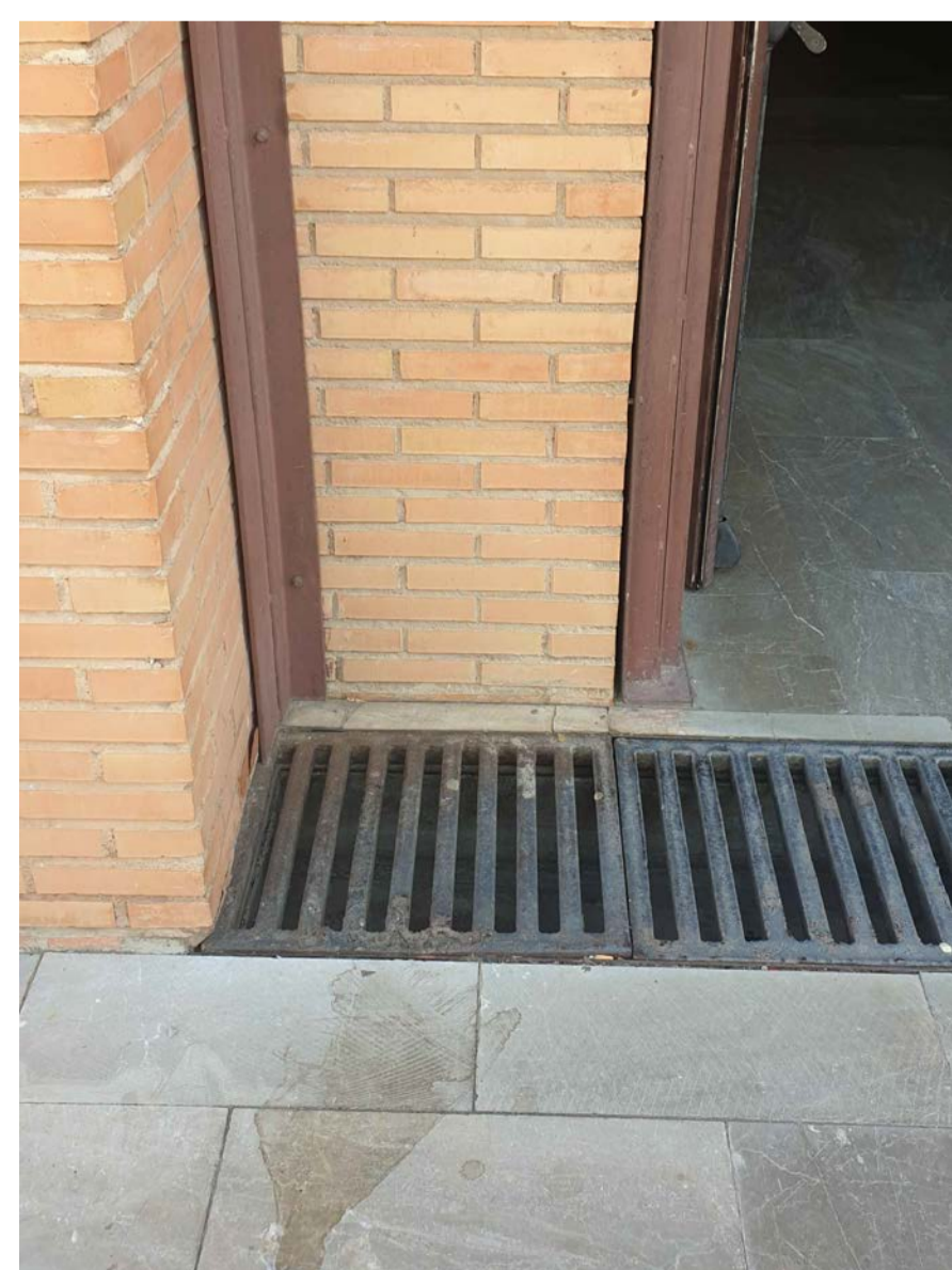
Acceso por fachada B: cambiar sumideros
