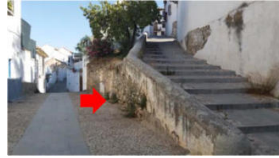
Ilustración 26. Calle Cruz de Quirós. Módulo empotrado en muro de contención existente entre viales.
