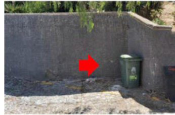
Ilustración 22. Calle Zenete. Módulo adosado en muro de contención existente de espacio libre público. Sustituye a contenedor en superficie.
