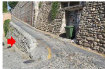
Ilustración 24. Carril de San Agustín. Módulo adosado en muro de contención de espacio libre público. Sustituye a contenedor en superficie.
