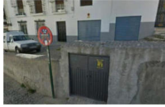
Ilustración 13. Calle Barrichuelo de Cartuja. Módulos semiempotrados.
