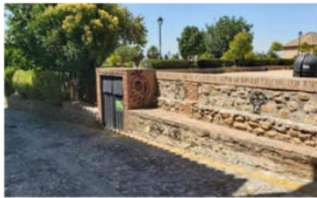
Ilustración 17. Calle Pilar Seco. Módulos semiempotrados.
