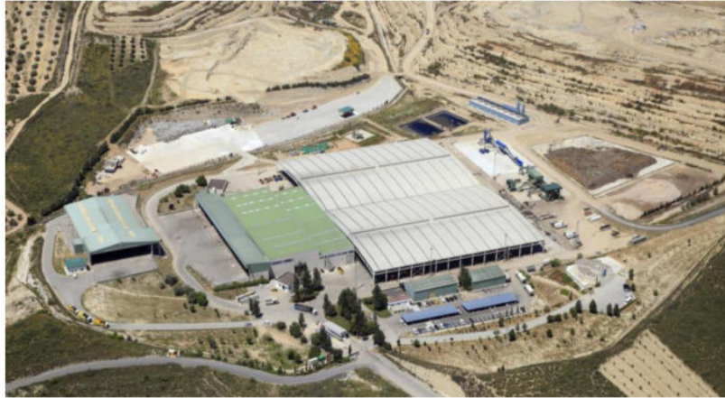
Figura 60: Vista aérea de la Ecocentral de Granada.
