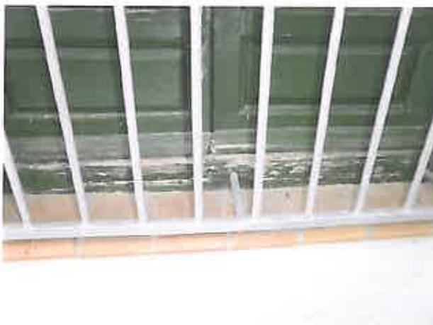
Sí se aprecia la pérdida de sección de la madera, en especial en las partes inferiores de las ventanas y balcones, haciéndose más evidente en los marcos y vierteaguas.
