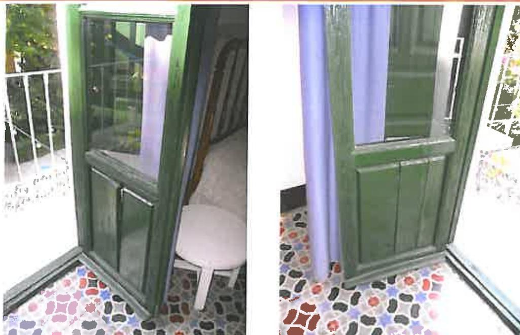
Las caras exteriores de las carpinterías, como consecuencia de la acción combinada de la lluvia y la radiación solar, se han visto sometidas a grandes modificaciones en el grado de humedad de la madera, en especial entre las capas internas y externas, favoreciendo la aparición de tensiones superficiales que han provocado la aparición de fendas y deformaciones de las hojas.
