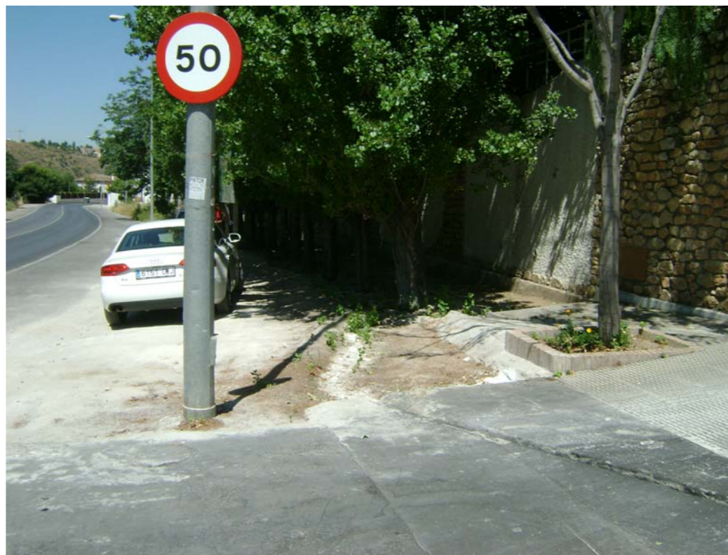
TRAMO - 3 ( FOTO Nº 5 )
