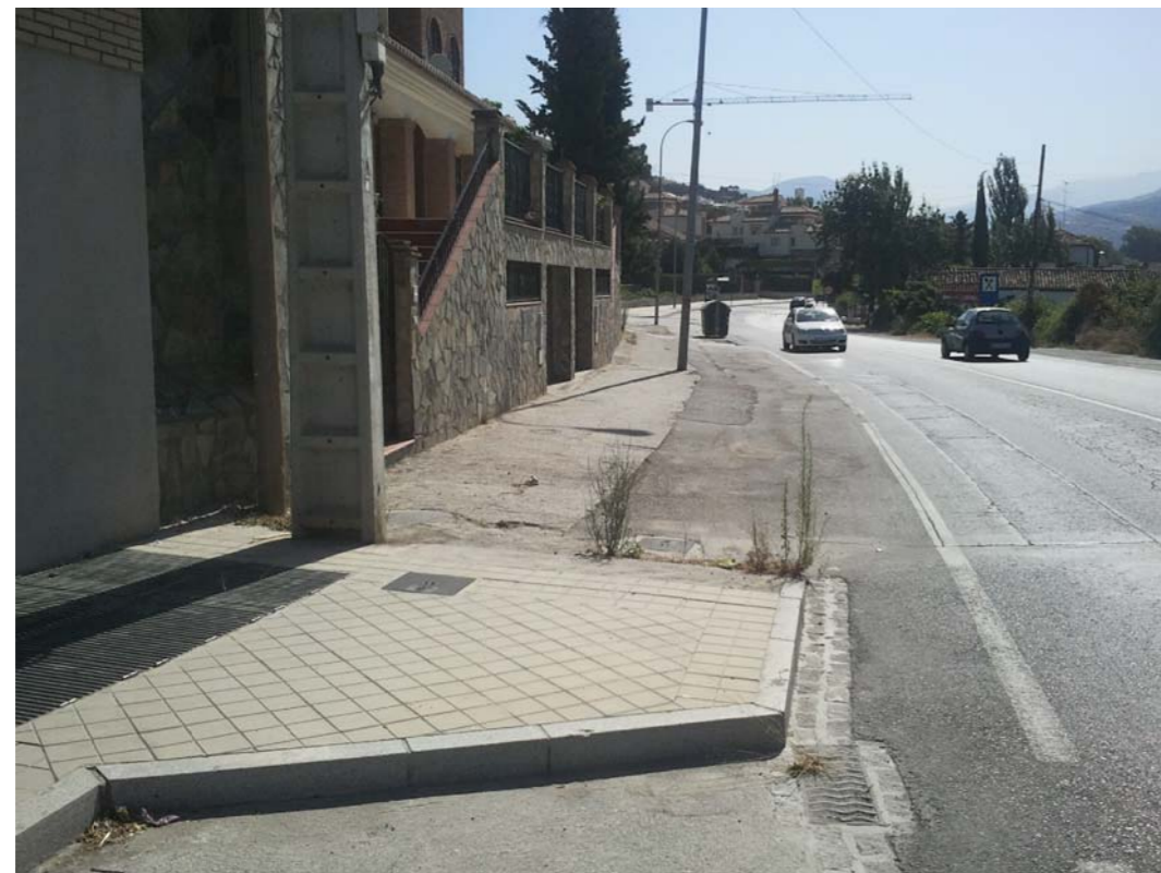
TRAMO - 2 ( FOTO Nº 4 )
