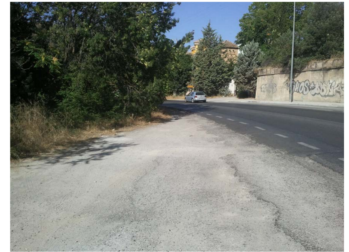
TRAMO - 1 ( FOTO Nº 3 )
